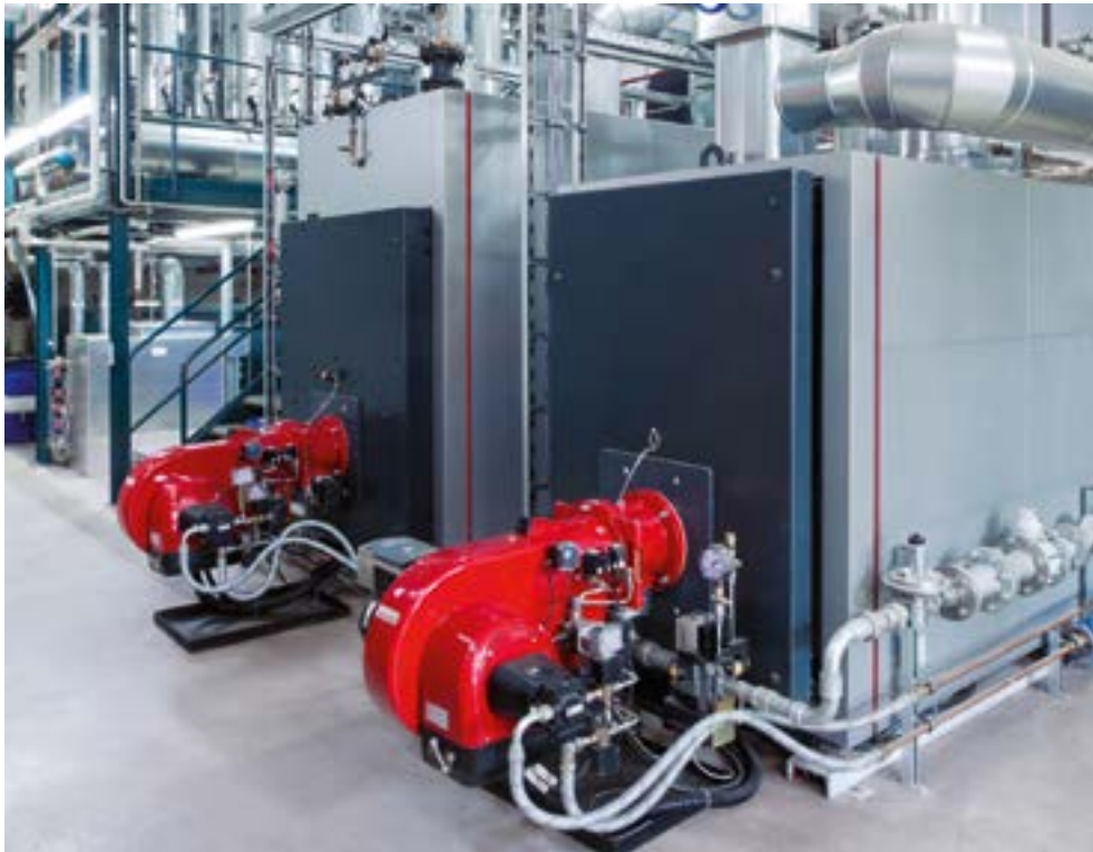
Типичное применение для небольших промышленных помещений: здесь используются Vitomax LCB и паровой котел низкого давления
