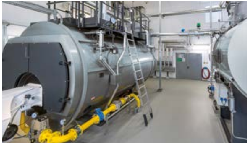
Котел Vitomax HS с паропроизводительностью 6 т/ч и давлением 10 бар
