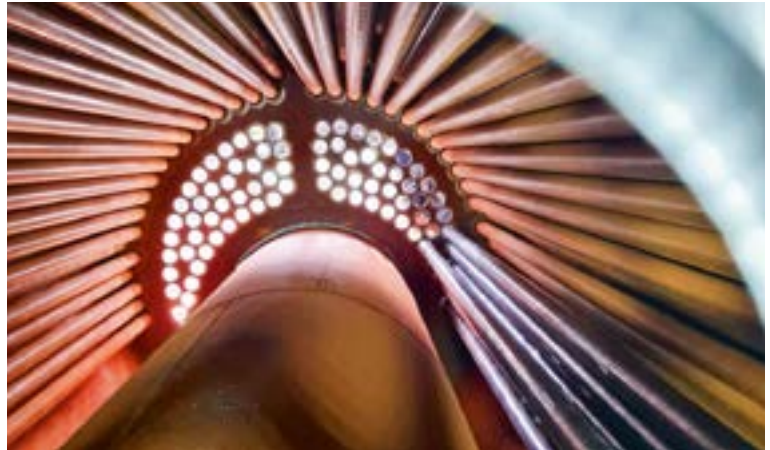
Проведение замены дымогарных труб второго хода водогрейного котла.
